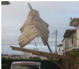
<飛来物による電柱倒壊（東金市）>
