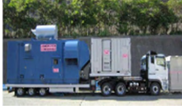
④-9 恒設代替電源設置
