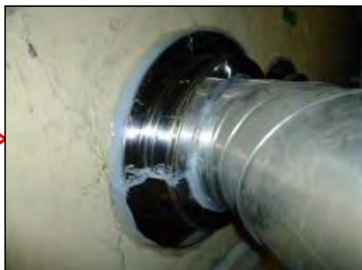
(例)配管設備の改造
