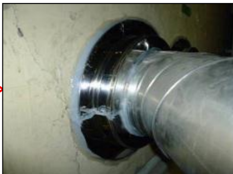
(例) 配管設備の改造
