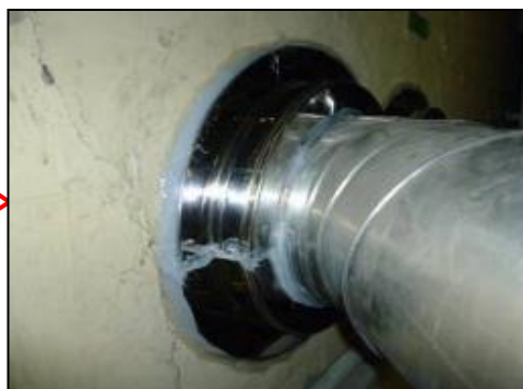
(例) 配管設備の改造
