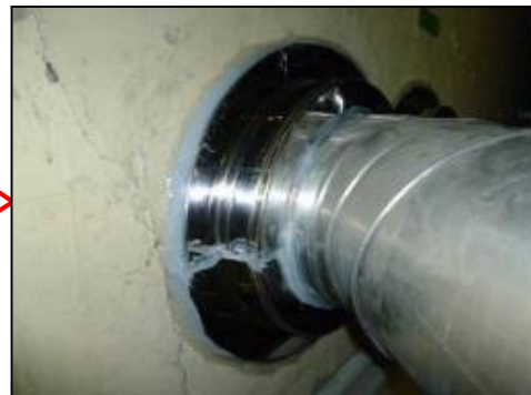
(例) 配管設備の改造
