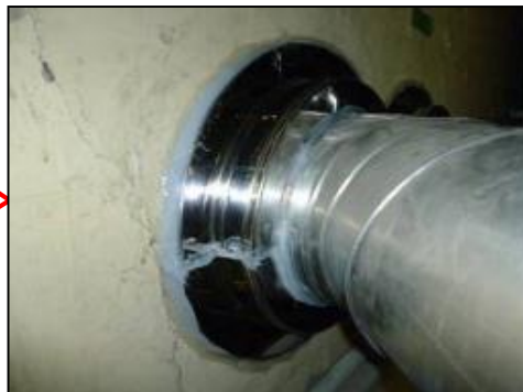
(例) 配管設備の改造
