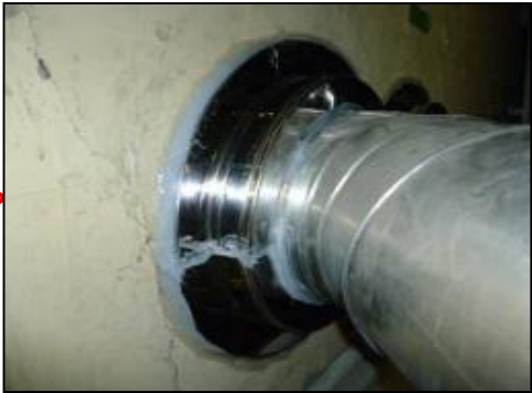
(例) 配管設備の改造
