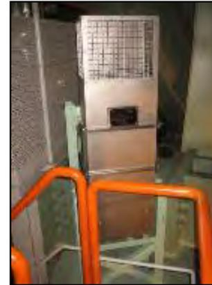
原子炉格納容器内に設置し、著しい炉心損傷に伴うジルコニウム-水反応等により短期間に発生する水素と事故後の長期にわたって緩やかに発生する水の放射線分解による水素を除去する。
