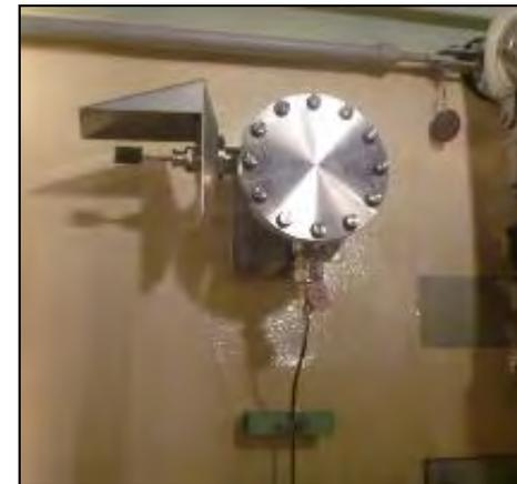
炉心損傷時に発生する水素は格納容器の健全性に影響を及ぼす水素爆発を起こす濃度に至らないことを評価しているが、さらなる安全性確保のため、炉心損傷時の短期間に発生する多量の水素を計画的に燃焼させることにより、初期の水素発生ピークを抑えることを目的としている。
