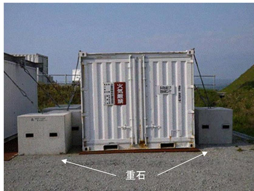
コンテナの飛散防止対策
