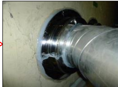
(例)配管設備の改造
