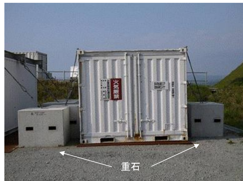
コンテナの飛散防止対策
