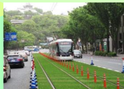
軌道敷緑化の整備 (熊本県熊本市)
