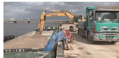
土砂運搬への船舶の利用
