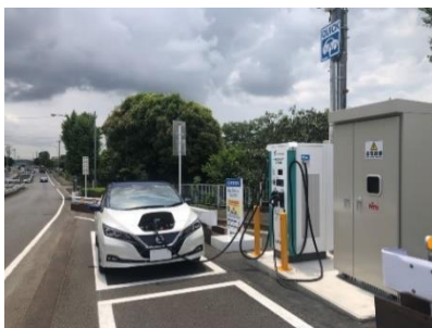
公道に設置されたEV充電施設（横浜市）
