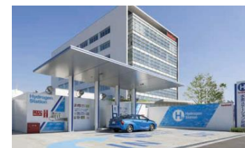
水素ステーション
