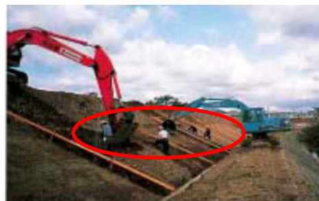
丁張りを確認しながらの施工
