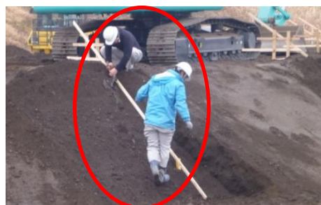
丁張り(目印)の設置
