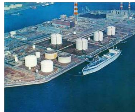
根岸LNG基地（東電・東ガス共同運営）
