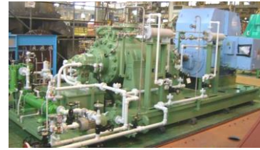
起動給水ポンプ (荏原製作所)
