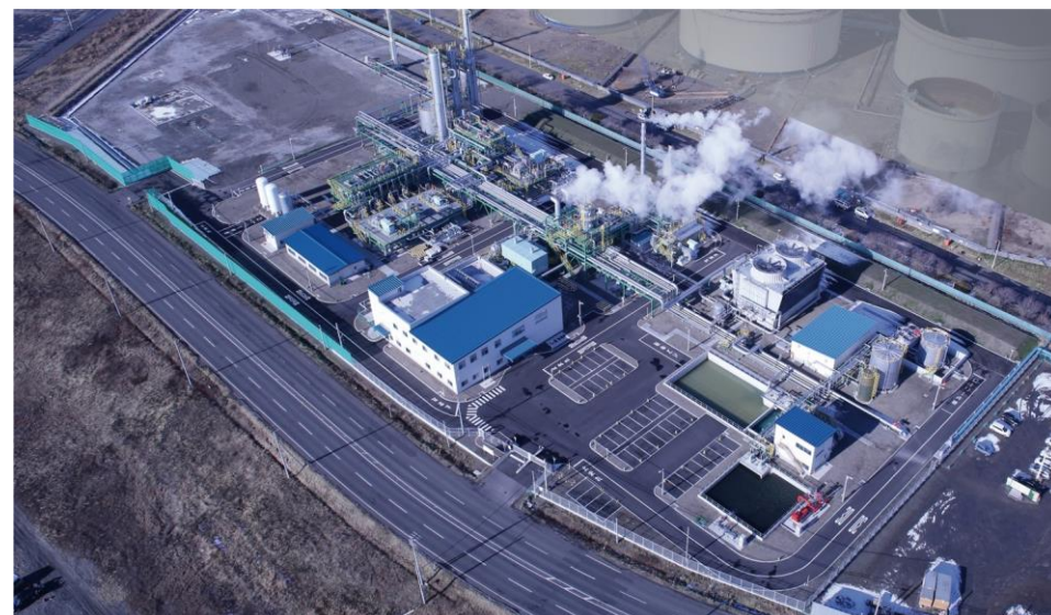
苫小牧CCS実証試験センター
