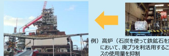
例) 高炉（石炭を使って鉄鉱石を鉄に変える炉）において、廃プラを利活用することで石炭・コークスの使用量を抑制
