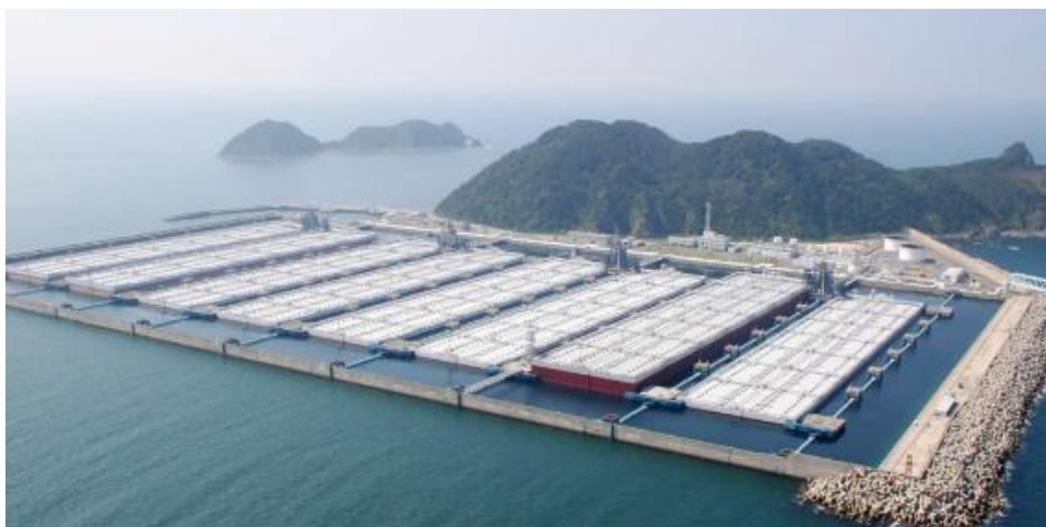
3/27(金) から国家備蓄原油の放出が開始された白島国家石油備蓄基地 出典：白島展示館HP ( https://museum.shirashima.jp/facility/ )
