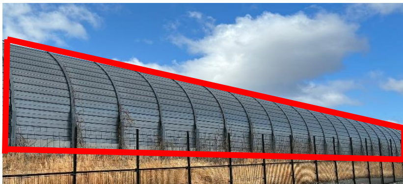
高速道路内の遮音壁の例（外壁） NEXCO西日本より提供
