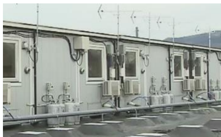
仮設住宅へのLPガス設置
