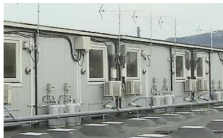
仮設住宅へのLPガス設置
