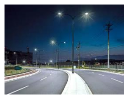
LED照明 (消費電力約56%削減)
