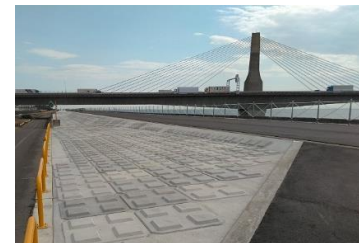
低炭素型コンクリート試行事例 (三重県桑名市長島町)
