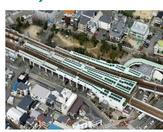
大物駅に導入された太陽光発電
