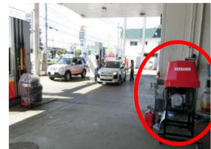
停電直後から、自家発電機を稼働させて給油を継続した中核SS
