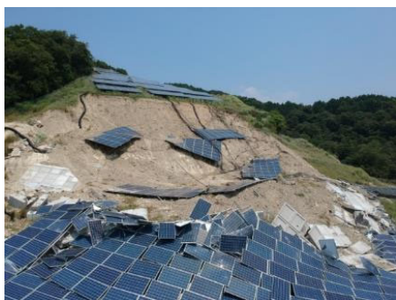
土砂崩れで生じた崩落
