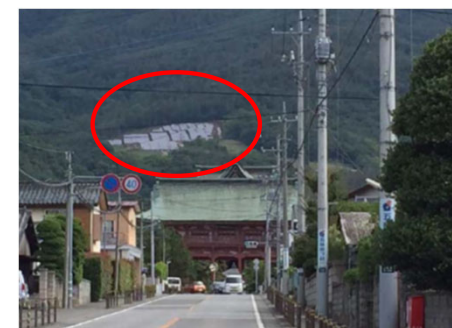
景観を乱すパネルの設置
