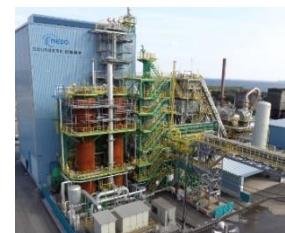
12m<sup>3</sup> 小規模試験高炉(水素還元)
