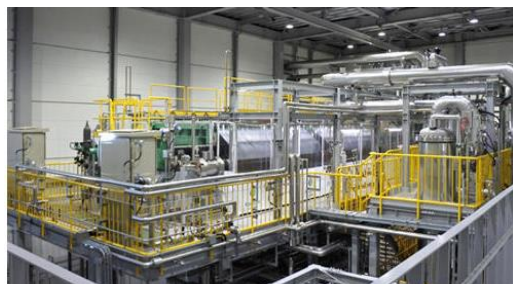
10MWの水電解装置
