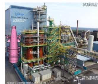
COURSE50試験高炉
