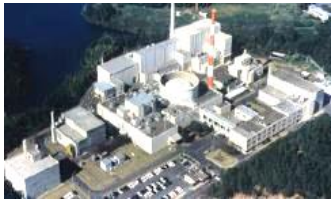
高速実験炉「常陽」
