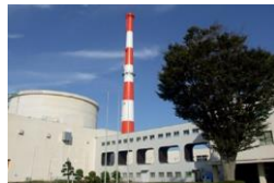
高速実験炉「常陽」
