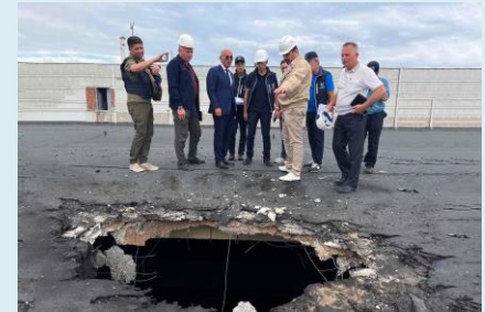
ザポリヅジャ原発施設の損傷状況を 確認するIAEA調査団（9/1）
