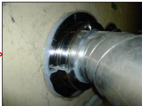
(例) 配管設備の改造
