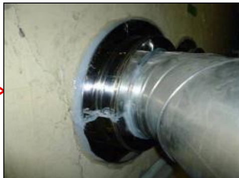
(例) 配管設備の改造
