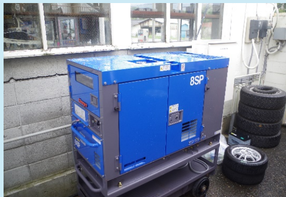
令和元年台風第15号の際に自家発電設備を稼働させて給油を続けたSS
