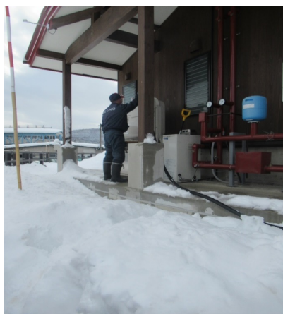
雪の中タンクローリーのホースを伸ばし給油作業にあたる配送スタッフ（新潟県妙高市）
