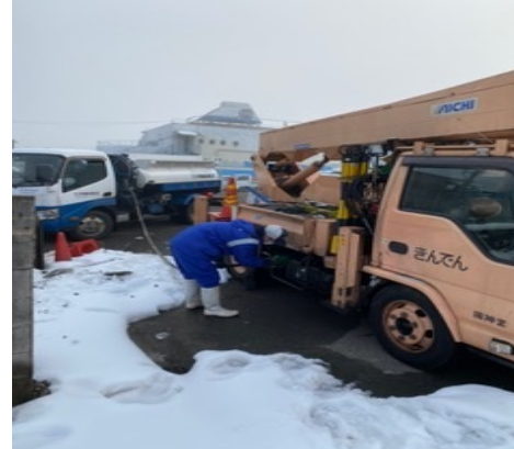
兵庫県香美町などで停電が発生。関西電力から高所作業車への緊急燃料配送要請があり地場SSがローリーで燃料を緊急配送
