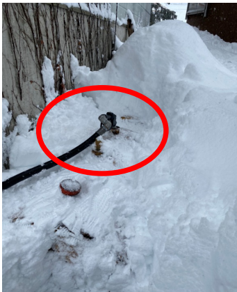
雪で埋もれた灯油ホームタンクの給油口を探し出し、灯油を供給（新潟県南魚沼市）
