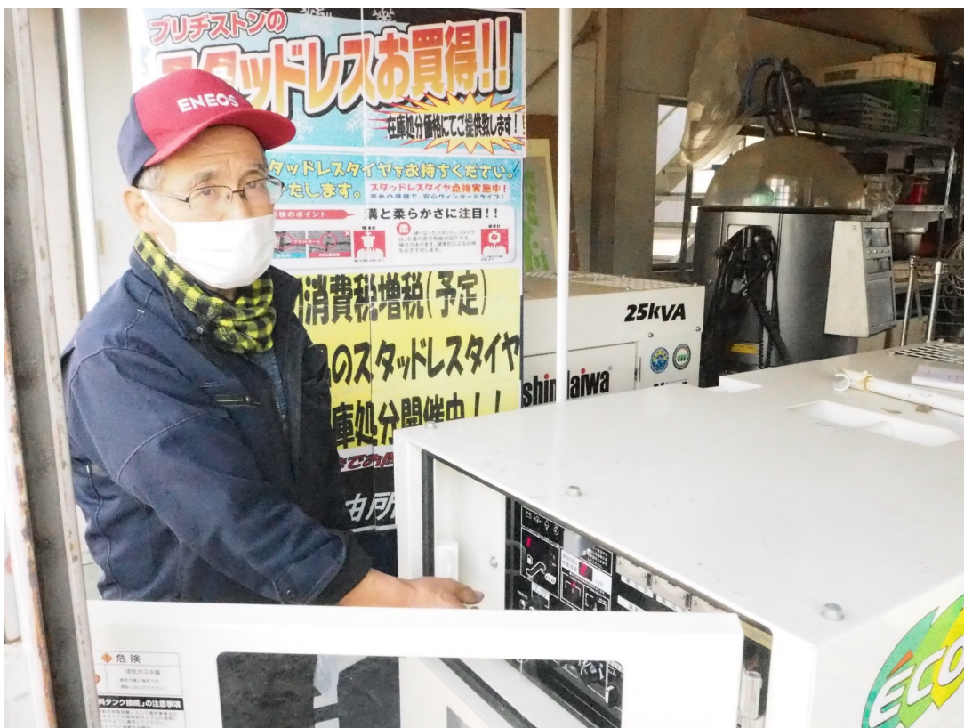
住民拠点SSであるオカダ石油ガス貝田SSでは、周辺地域一帯が停電となったため、急きよ、自家発電設備を稼働させ、深夜から燃料供給を再開し、地域住民らの給油要請に応えた（2021年2月14日撮影）
