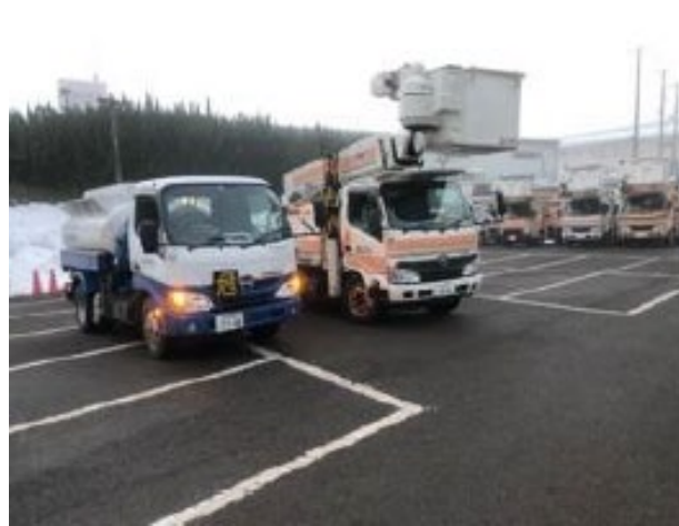
停電の復旧を行う高所作業車に対する燃料給油を実施
