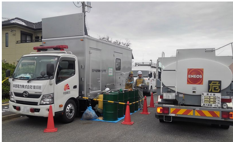
令和元年台風15号対応における電源車への燃料給油
