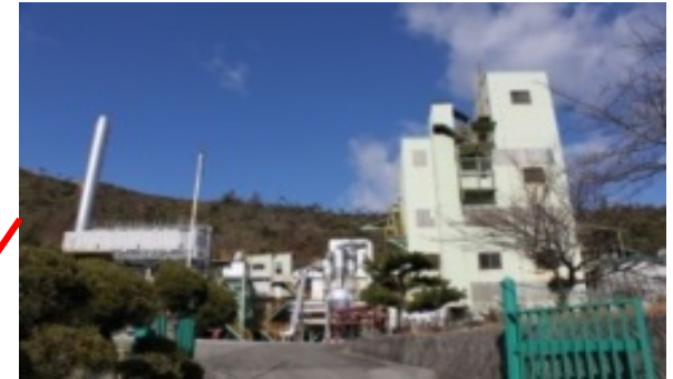
大容量燃焼試験設備 (兵庫県相生市)
