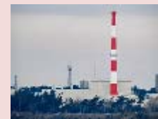
常陽 (高速実験炉)
