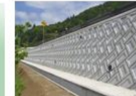
護岸ブロック
