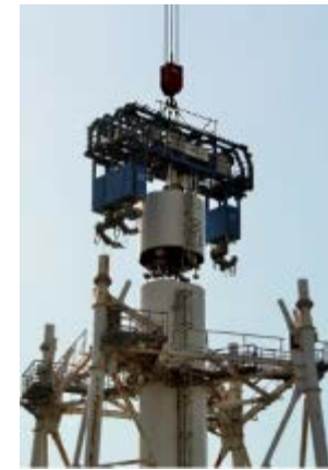
遠隔による解体作業
