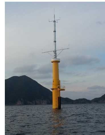
洋上風況観測タワー （五島市樫島沖）
