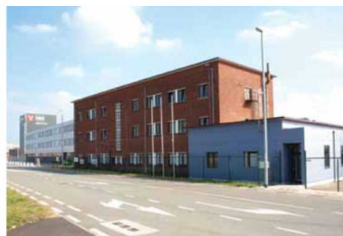
Servion Benelux Deme Offshore
