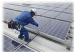
太陽電池外観点検
