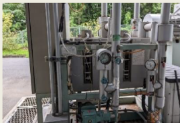
凍結対策を実施したドラムレベル計、ボイラ薬品ライン
