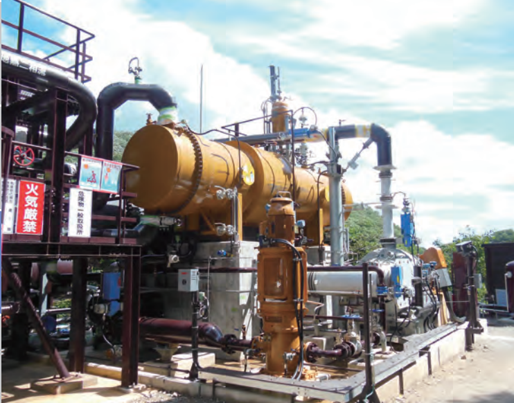
▲土湯温泉16号源泉バイナリー発電所
