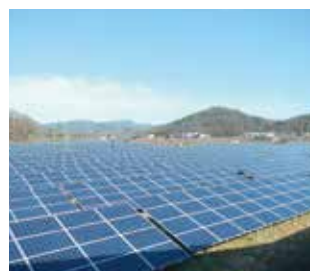
▲展望デッキから見た太陽光発電所
