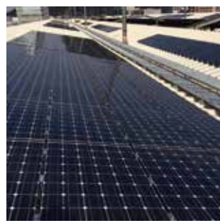
▲東北新幹線ホーム屋根の軽量型太陽光パネル
