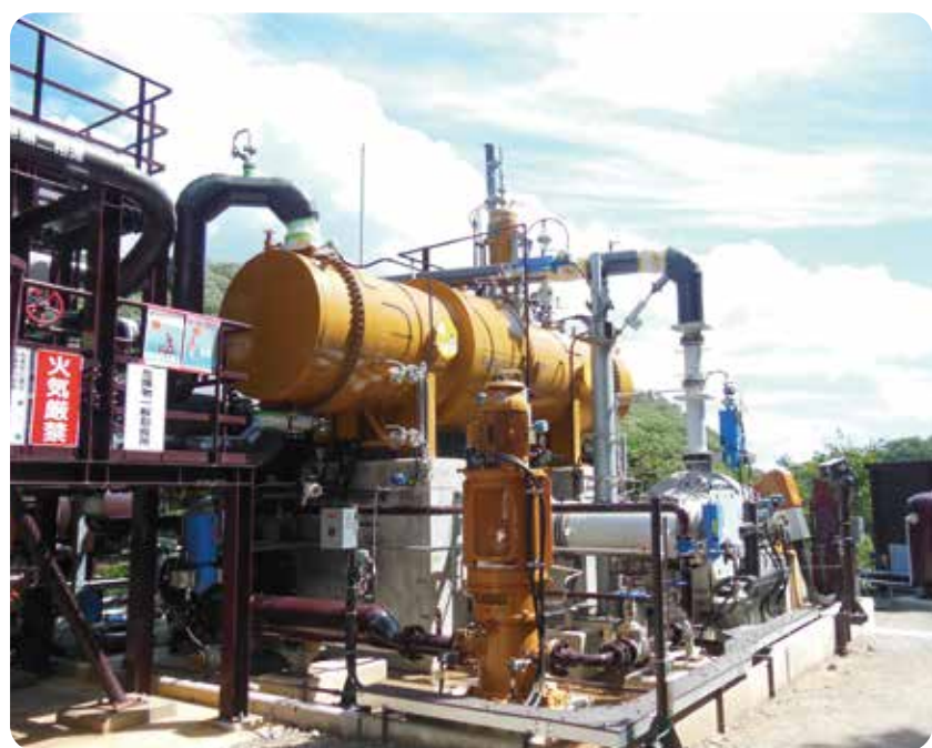
▲土湯温泉16号源泉バイナリー発電所
