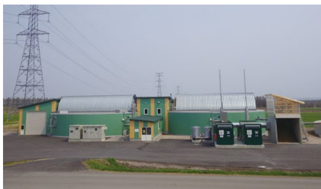
バイオガスプラント
