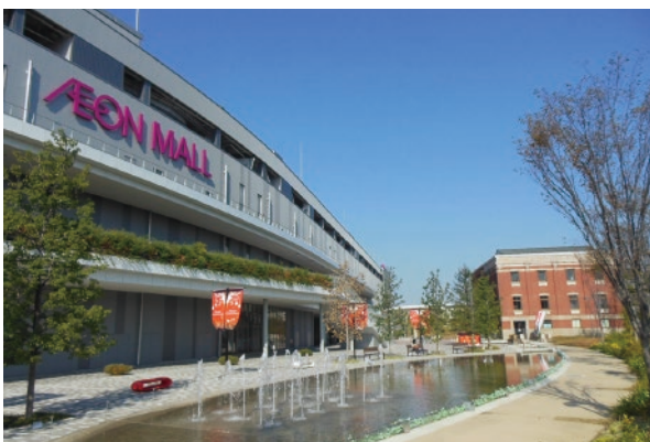
イオンモール堺鉄砲町と下水再生水を水源とした小川（せせらぎ）
