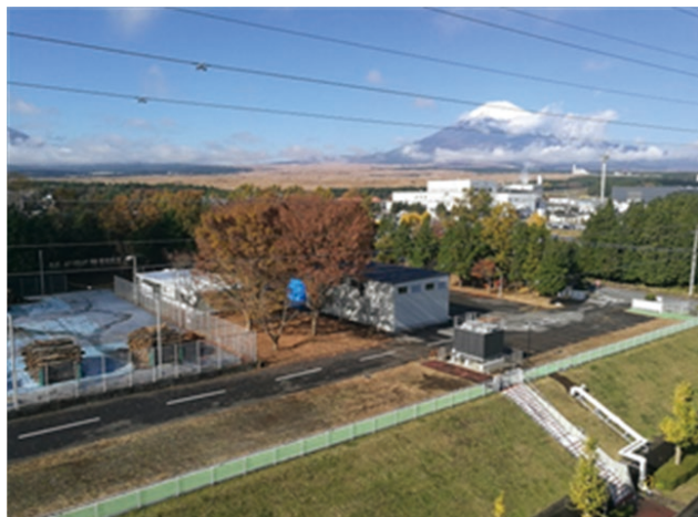
木質バイオマスエネルギープラント
