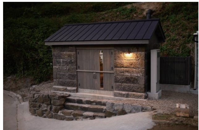
石積みの発電所建屋
