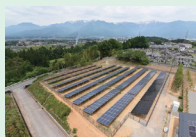
リユース品を使用した発電所
