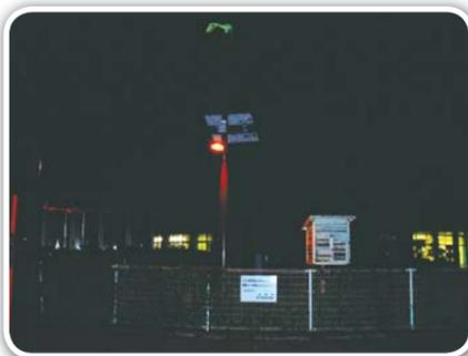
**特長** 再生可能エネルギーで発電した電力は、システム内蔵のバッテリーに蓄電され、夜間照明を点灯させます。蓄電した電力を利用しているため、電力のない場所や停電時でも照明を利用することができます。
