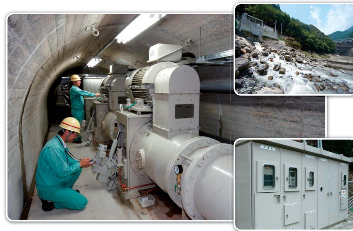
**特長** 放水管のある既設トンネルをそのまま利用するため、2つの小型汎用発電設備を直列に設置しています。また、ダム水位が変動しても流量が一定となるよう、流量制御機能(直列設置形態で国内初)を設けています。
