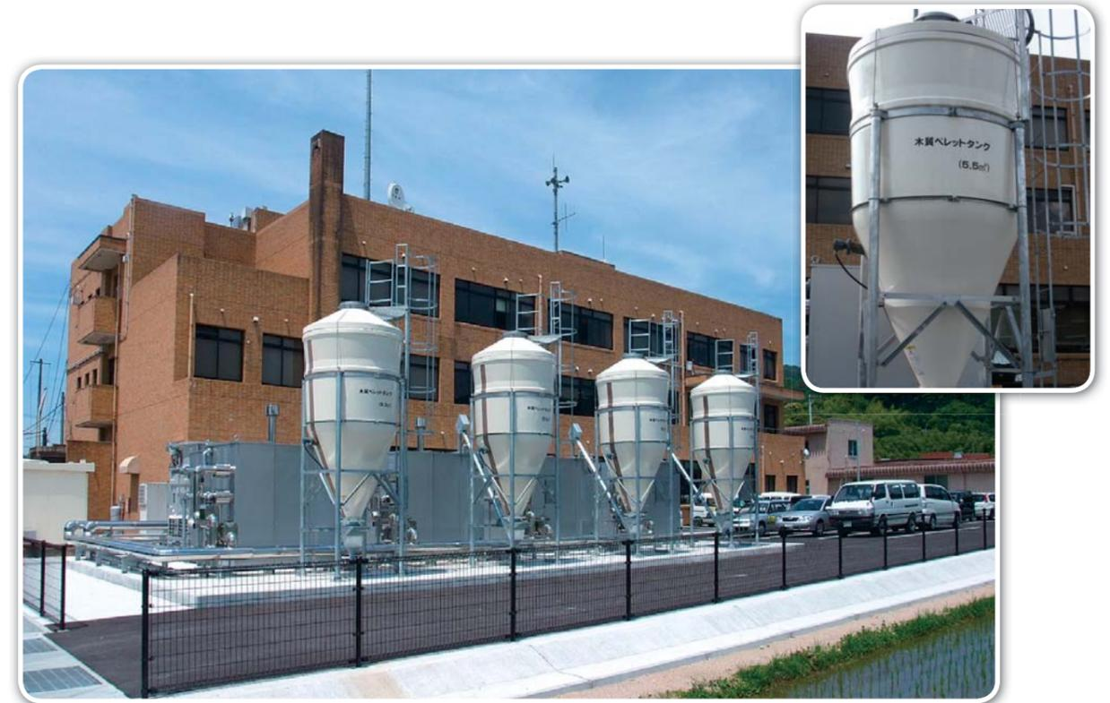
**特長** 屋外設置により、設備投資コストを抑えています。また、操作盤による室内からの遠隔発停、冷暖自動切替、スケジュール管理、ペレットの残量管理ができ、安心して運転ができます。
