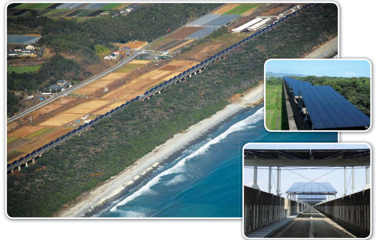
**特長** リニアモーターカー実験線上に長さ約3.6kmに渡り太陽光パネルを設置した、世界でも類を見ない形状の発電所です。日向灘に面した立地環境から、耐風強度、錆や腐食に強い耐久性に配慮した設計を施しています。
