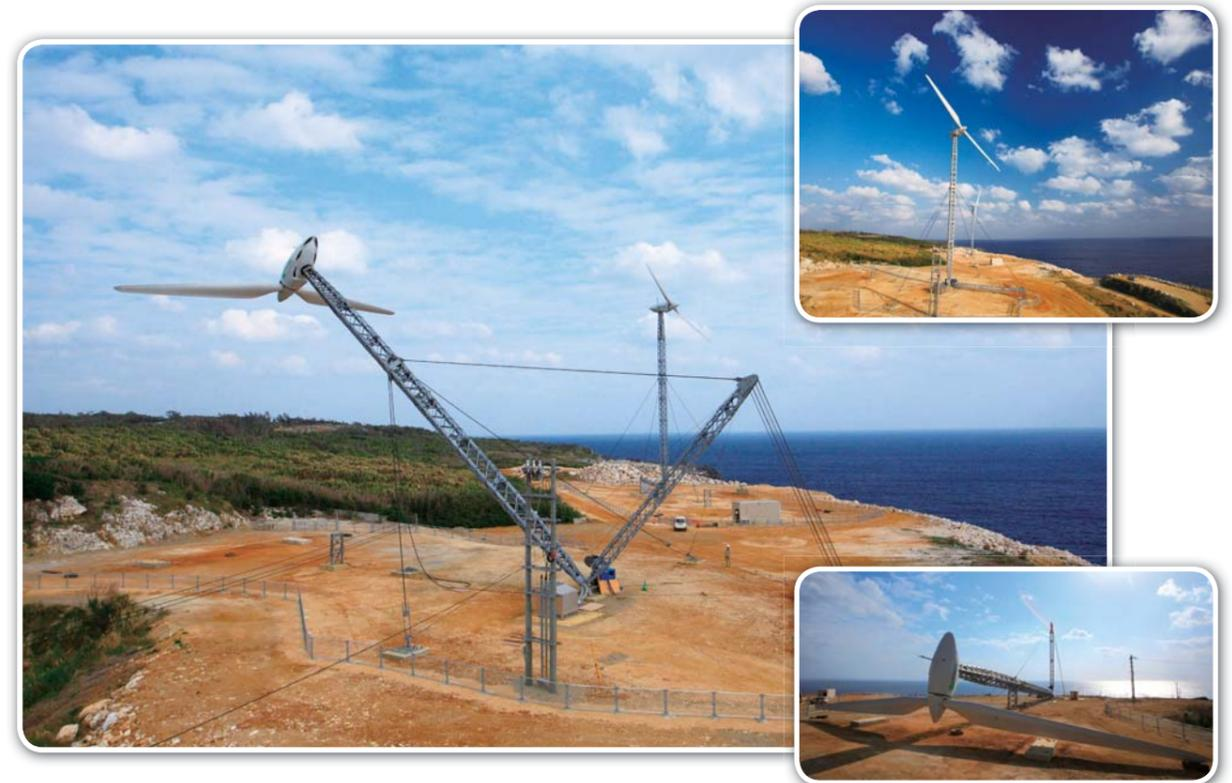
**特長** 風車タワーを90度近く傾倒できる「可倒式風車」を導入することにより、台風などの強風被害を回避可能です。建設および補修に大型クレーンは不要で、比較的丘陵地にも建設が可能です。
