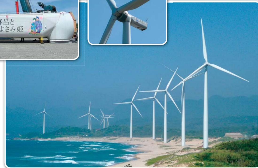
**特長** 風車発電機は永久磁石励磁同期発電機であるため、増速機・クーラー・主軸などが不要となり、その結果、他形式の発電機と比較すると、①高効率・高性能 ②高い信頼性 ③低騒音 ④低いメンテナンスコスト ⑤系統への影響が少ないなどの特長を持ちます。
