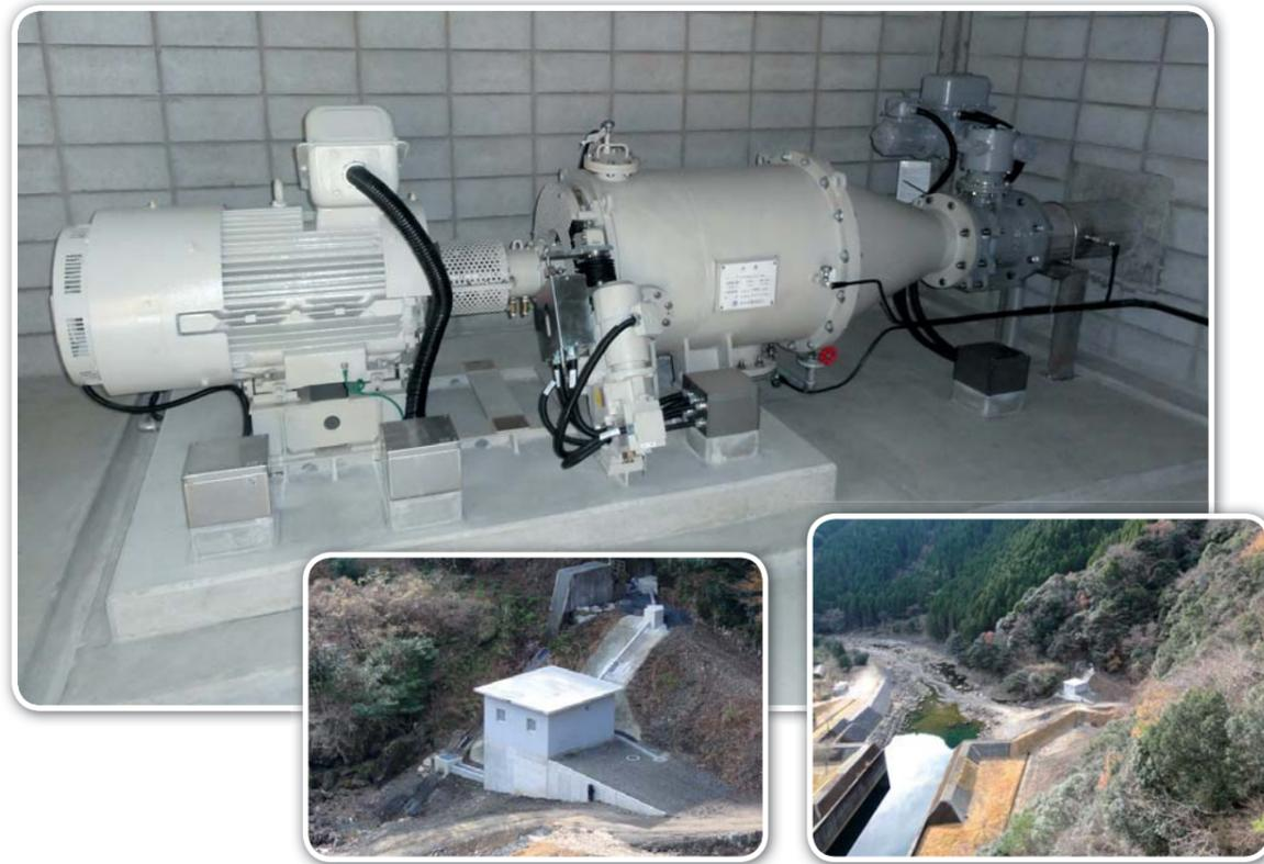
**特長** 宮崎県企業局で初めてのダムの維持流量を活用した発電施設です。ダムの変落差にも対応できる機器を採用し、常に安定した維持流量を確保しています。
