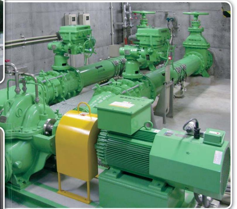
**特長** 稼働中の浄水場導水管に設置することから、管路への影響および取水量制御の円滑、並びに発電効率を考慮し、回転数制御方式を採用しています。
