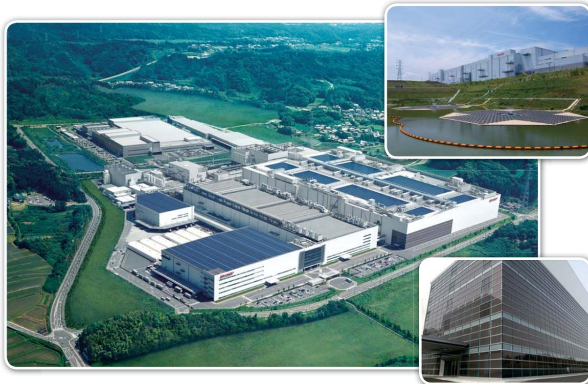
**特長** 建物設置タイプの太陽光発電としては、世界最大級の規模で一般家庭約1,300軒分の電力使用量に相当します。また、工場カーテンウォールには、採光しながら発電する「シースルー型薄膜太陽電池」を採用しています。
