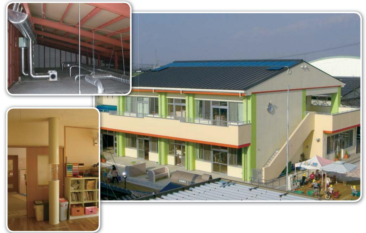
**特長** 太陽の熱で空気を温め、冬は温かな空気を床下に送り各保育室を温め、夏は貯湯槽内の水を温め温水シャワーに利用します。保育園という施設のため、火を使わない暖房設備は安全面でも役立っています。
