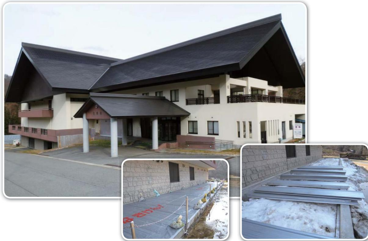
**特長** 貯雪冷房システムは、地下に設置された約600㎡の貯雪庫に雪を貯め、その融雪水を使って冷気を館内に送る冷房システムです。冷房エネルギーを低く抑えるために、20℃前後の吹き出し温度で冷房します。
