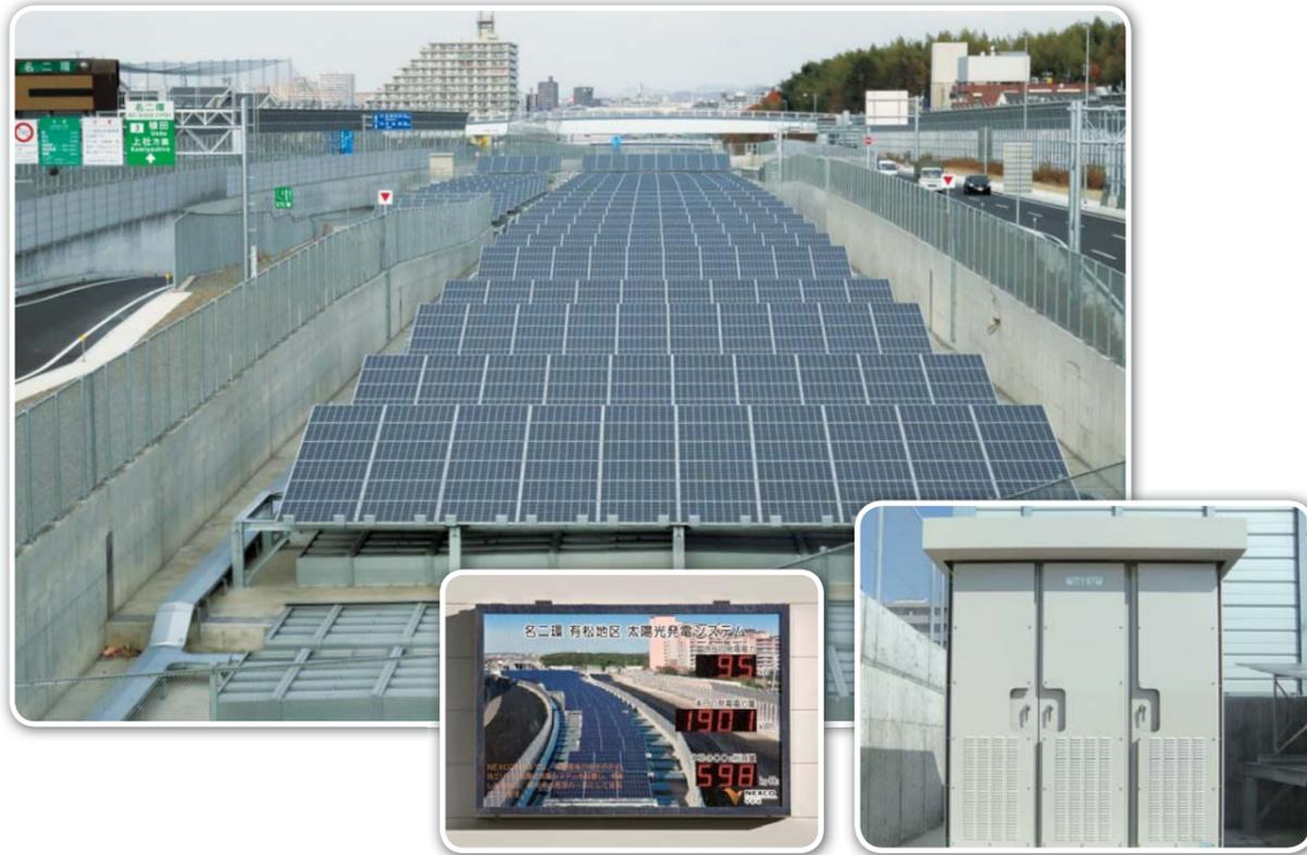
**特長** 名古屋第二環状道路は、南北に延びる掘割構造の高速道路で太陽光発電の設置には最適といえます。その掘割部上部に太陽光パネルを南向きに配置し、掘割部トンネル照明の屋間に要する電力を太陽光発電で賄います。
