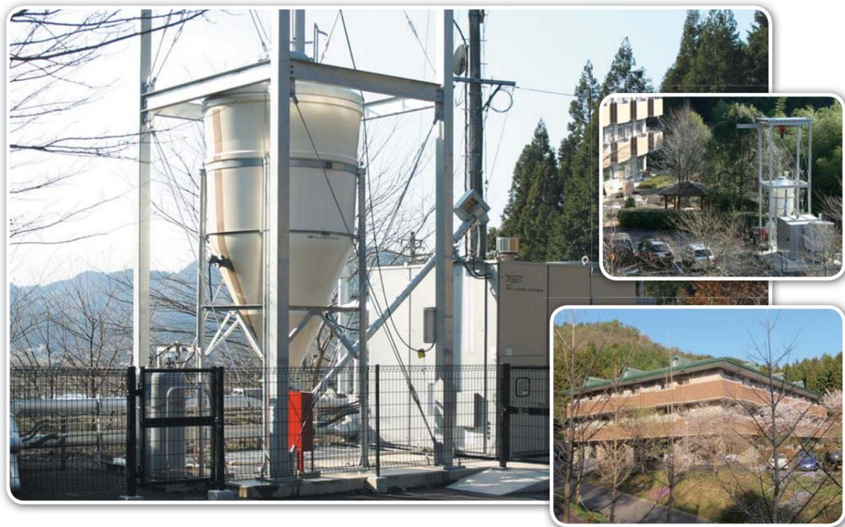
**特長** 木質ペレット直焚吸収冷温水機方式は、従来方式の木質ペレット焚ボイラー + 温水焚吸収冷温水機では損失していた熱量をロスすることなく使用できるので、総合効率において優れています。
