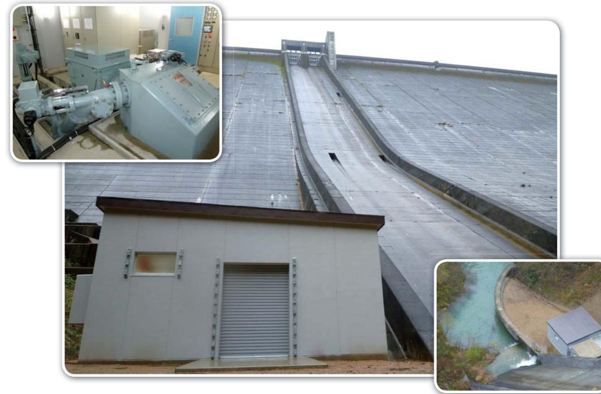
**特長** 標高1,000m以上の場所に位置し、冬期には積雪が4mを超えるため、発電所建屋は積雪や雪崩に耐えられるよう頑丈に設計されています。
