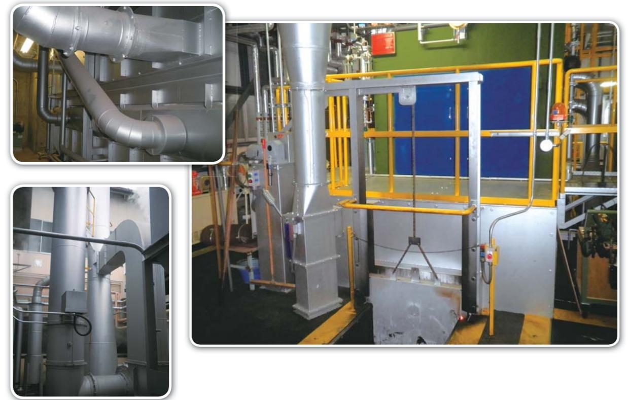
**特長** 2段燃焼構造で木屑を完全燃焼し、さらにマルチクロン集塵機により黒煙の発生をおさえ周辺環境に配慮した構造です。また燃焼室に水管を配置し木屑の燃焼効率をあげることで蒸気の発生を安定させ、エネルギー効率80%以上の最新型ボイラー施設となっております。
