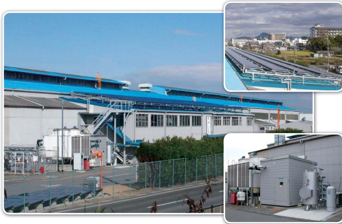
**特長** 川重冷熱工業は将来のソーラーナチュラルチラーとのパッケージ化を意識して補機類をコンパクト&シンプル化、ソーラーナチュラルチラーに集熱設備の制御やモニター機能を組み込み、導入におけるハードルの引き下げを図っています。
