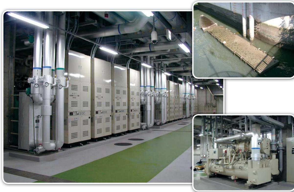
**特長** 日本で唯一の冷却塔を持たず河川水を熱源として100%利用している地域冷暖房プラントです。また、取水と排水の河川を分けることにより、満潮時河川の逆流による熱のショートサーキットを防止しています。
