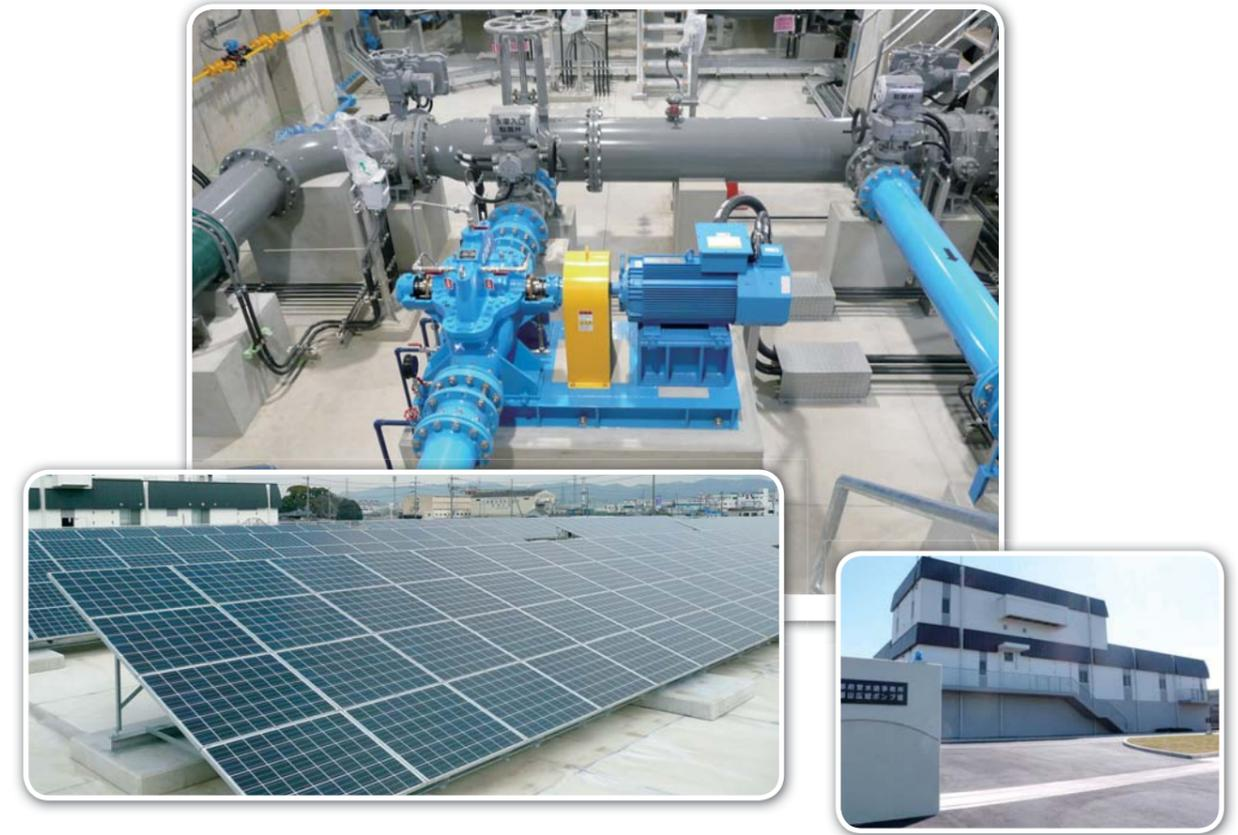
**特長** 久御山広域ポンプ場では、乙訓浄水場からの約80mの水位差を利用した小水力発電と配水池屋上のスペースを有効活用した太陽光発電の2つの発電設備を系統連系させながら運転しており、施設の使用電力の一部を賄うと共に余剰電力を売電しています。
