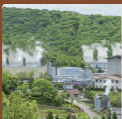
地下に蓄えられた地熱エネルギーを蒸気や熱水などで取り出し、タービンを回して発電します。使用した蒸気は水にして、還元井で地中深くに戻されます。日本は火山国で、世界第3位の豊富な資源があります。
