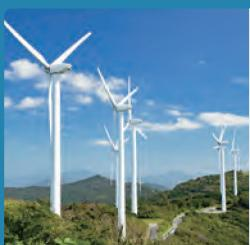
風のチカラで風車を回し、その回転運動を発電機に伝えて電気を起こします。
