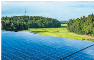
■メガソーラー発電所
