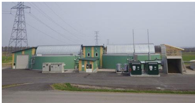
バイオガスプラント
