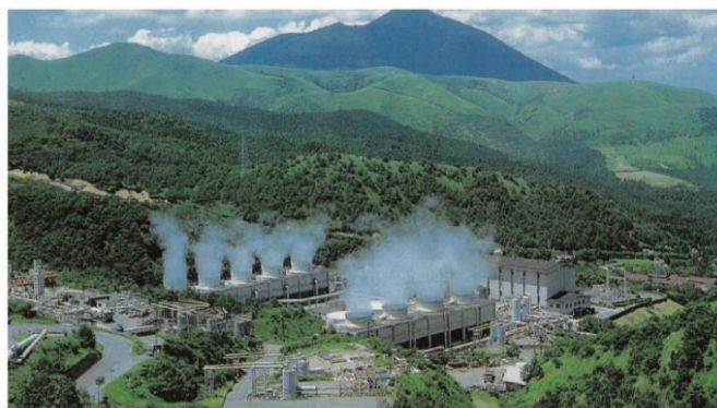
地熱発電所の冷却塔から立ち上る白煙の様子 （八丁原地熱発電所）（出典：九電みらいエナジー株式会社「八丁原発電所パンフレット」）
