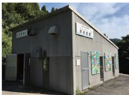
建屋 発電所建屋の外観
