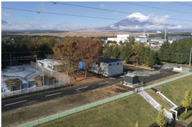
木質バイオマスエネルギープラント
