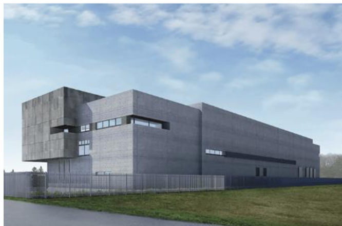
データセンター外観イメージ
