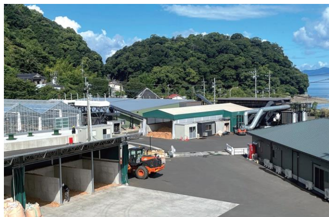
木質バイオマス熱電併給プラント及び周辺施設
