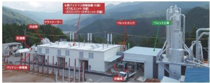
内子バイオマス発電所
