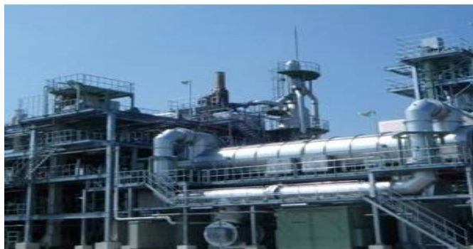
汚泥燃料化施設全景
