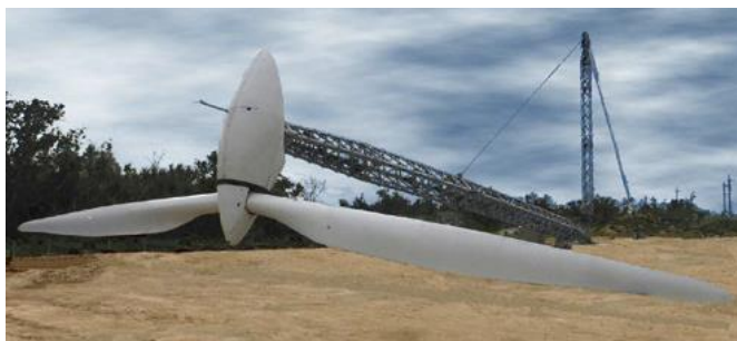
風車傾倒時の様子
