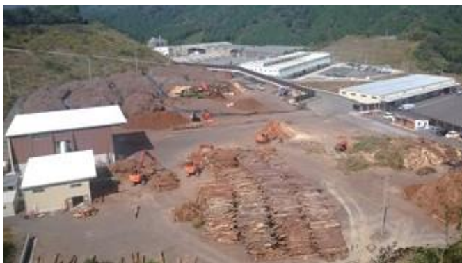
真庭バイオマス集積基地（木質資源収集・集積・供給拠点）
