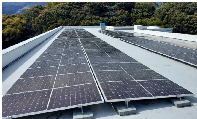
学校屋上への太陽光パネル設置
