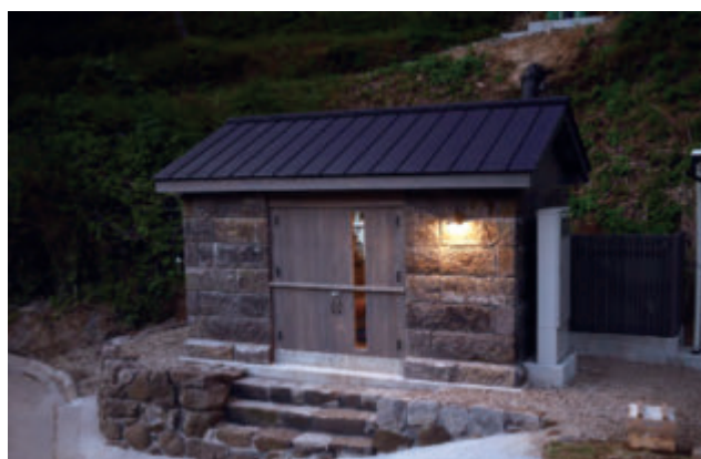
石積みの発電所建屋
