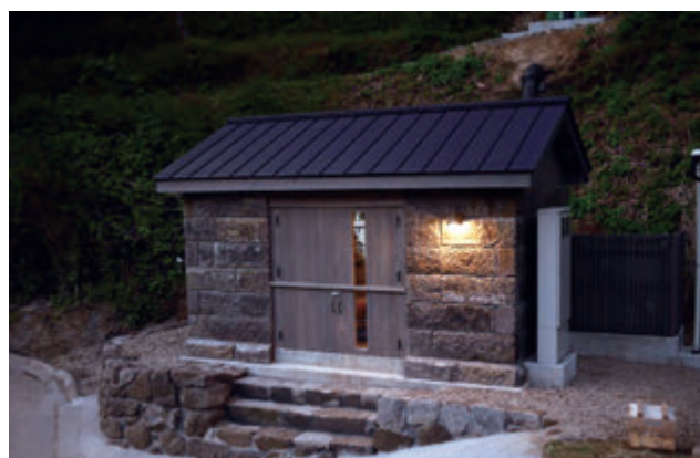
石積みの発電所建屋
